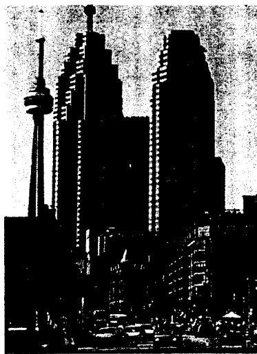
Рис. 1.18. Багатоповерхові будівлі з металевим каркасом
