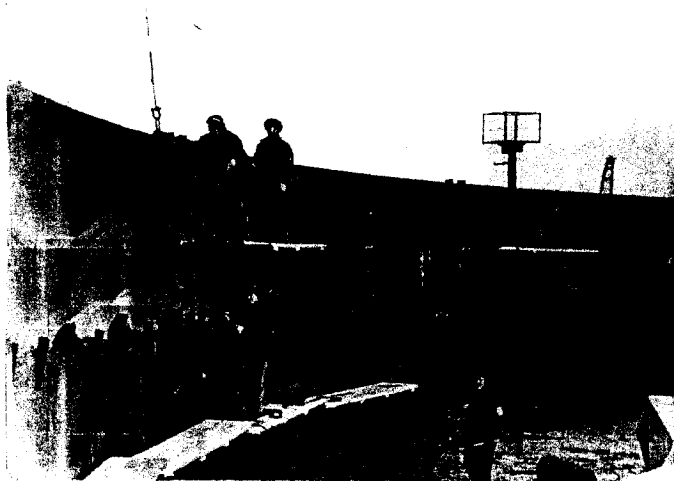
Рис. 1.8. Монтаж вертикального резервуару
