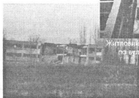
Зруйнована споруда дит. садка
