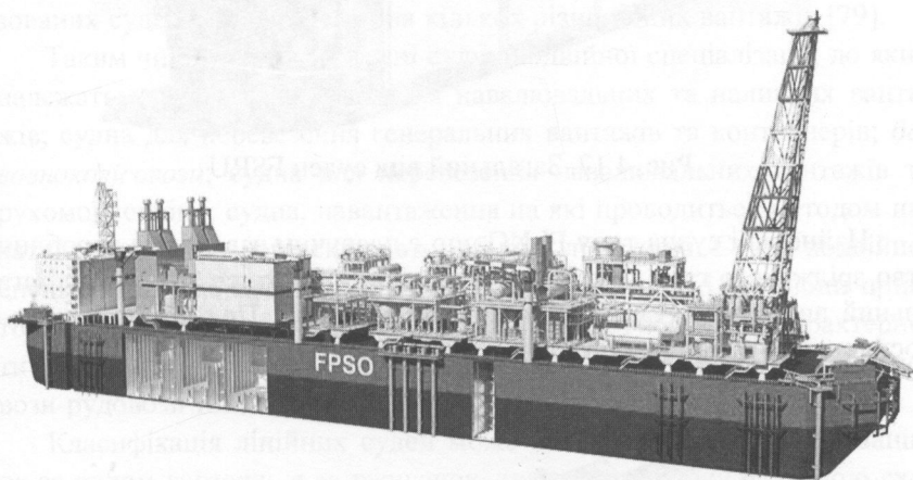
Рис. 4.16. Загальний вид суден FPSO
