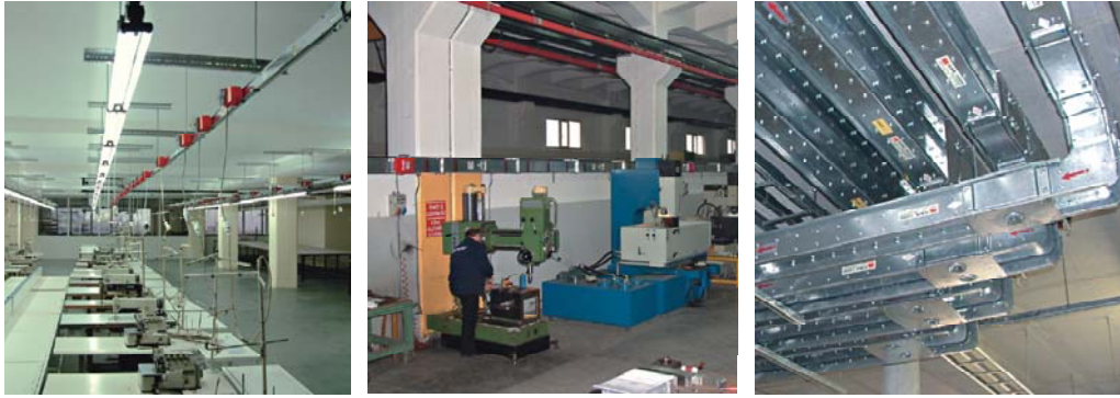
Рис. 4.140. Приклади застосування систем збірних розподільних шинопроводів
