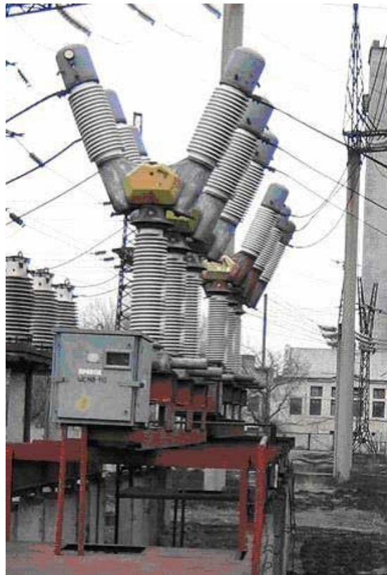
Рис. 4.104. Маломасляні відмикачі типу ММО-110: номінативна напруга – 110 кВ; номінативний струм – 1250 та 1600 А; номінативний струм відмикання (здатність до відмикання коротких замикань) – 20 кА та 31,5 кА; актуатор – пружинно-моторний
