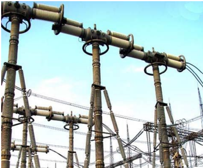
Рис. 4.105. Три колонки полюсу відмикача ВНВ-750 (на передньому плані)
