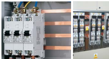
Рис. 4.139. Збірні шини як засіб монтування комутаційних апаратів
