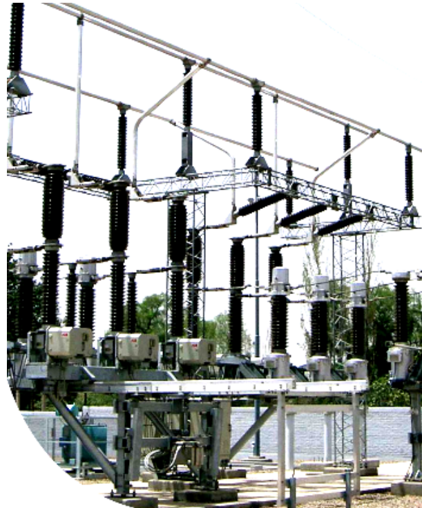
Рис. 4.109. Елегазовий викатний відмикач (на передньому плані – рейки для викочування)
