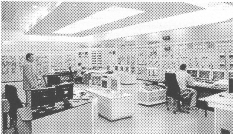
Рисунок 7.1 – Автоматизована система контролю та керування розподілом електроенергії
