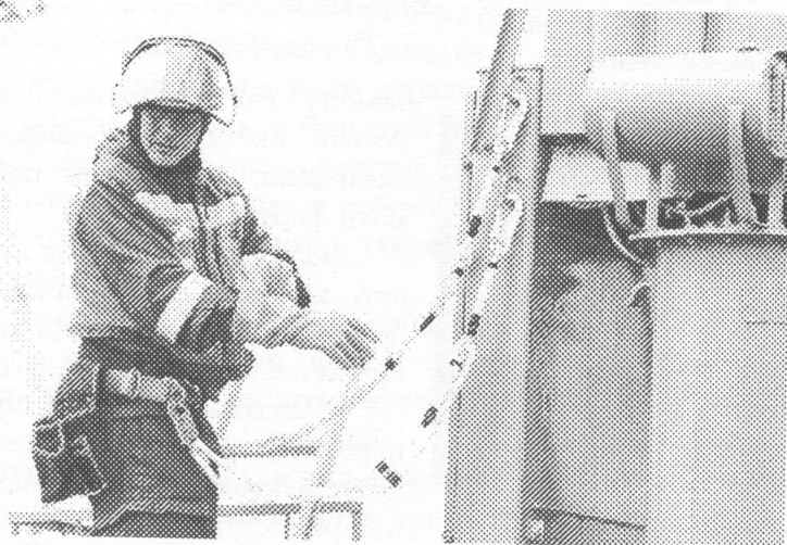
Рисунок 11.7 – Екіпіровка при роботі з електрообладнанням
