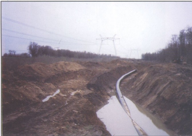
Фото 70. Будівництво магістрального трубопроводу
