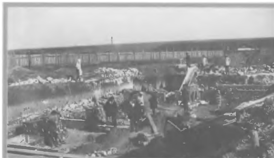
Рисунок 1.6 – Будівництво Дніпровського магнієвого заводу
