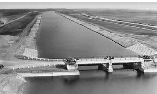
Шлюз на Північно-кримському каналі. 1960-і.
