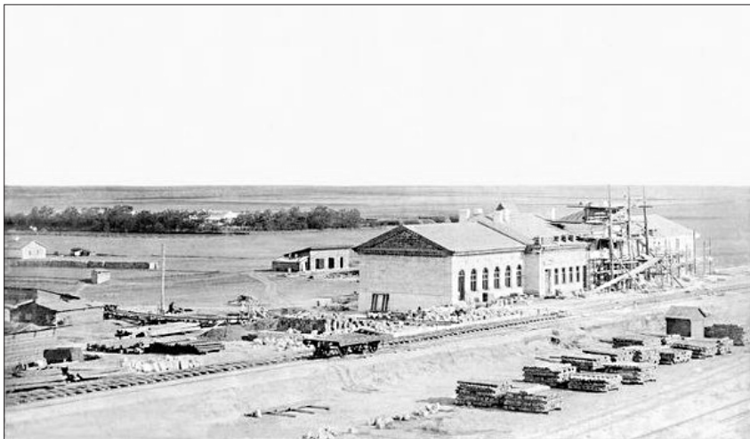
Джанкой, будівництво залізничної станції, 1903 р.
