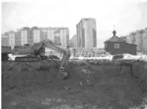
Рис. 4.2. Виймка ґрунту під котлован
