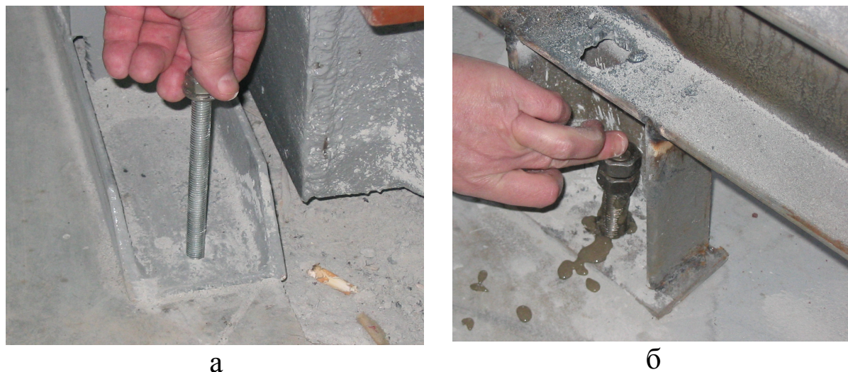
Рис. 6.10 – Встановлення анкерного болту в свердловину, заповнену акриловим клеєм
