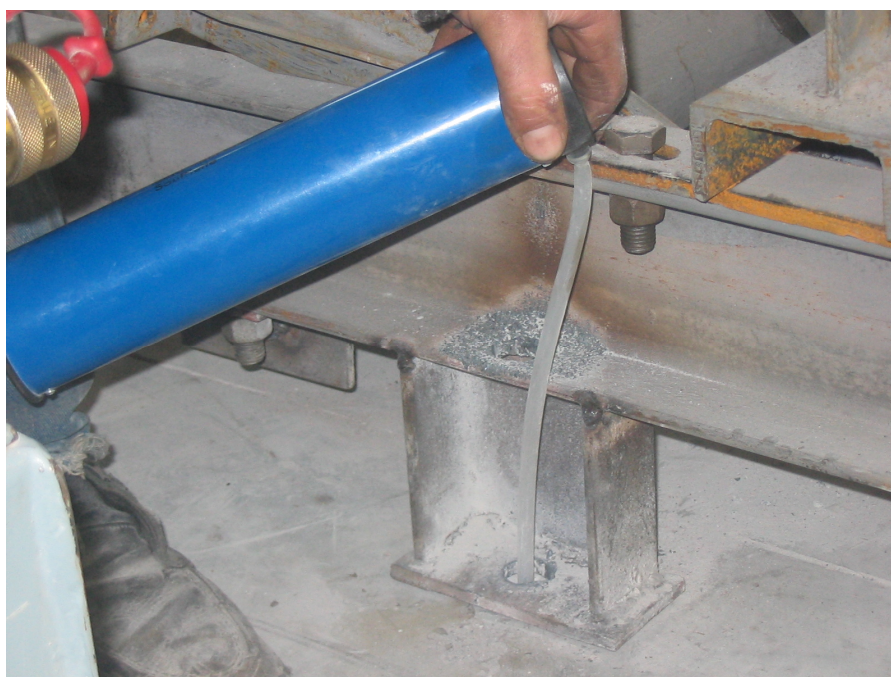
Рис. 6.8 – Продувка свердловин у бетоні стиснутим повітрям за допомогою спеціального устаткування
