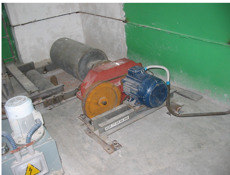
Рис. 6.13 – Приводна станція транспортера, закріплена анкерними болтами на акриловому клею
