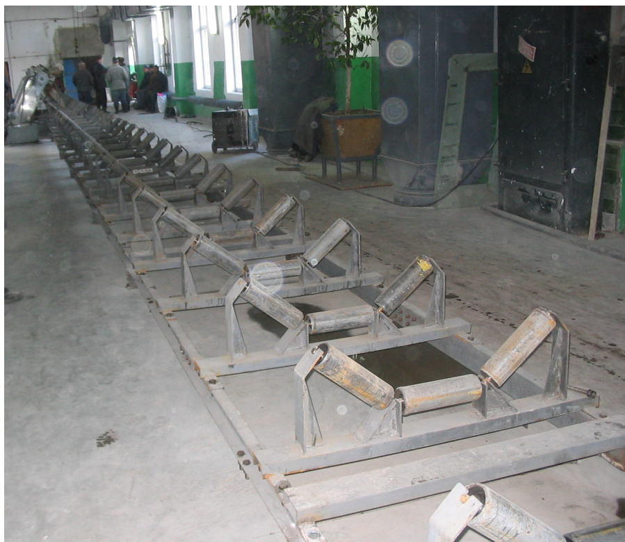
Рис. 6.12 – Загальний вид конструкції транспортеру, закріпленого анкерними болтами на акриловому клею
