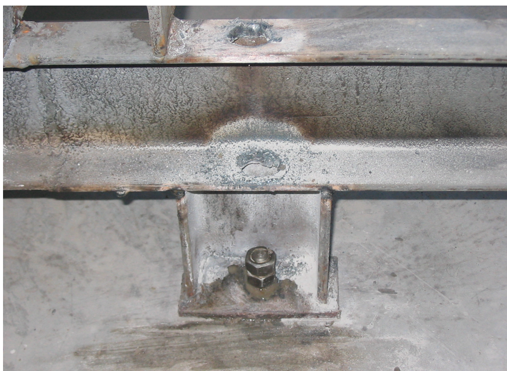
Рис. 6.11 – Вид вузла кріплення обладнання
