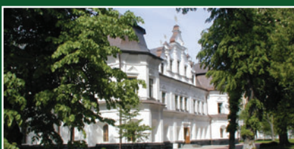
НАЦІОНАЛЬНИЙ ЗАПОВІДНИК "СОФІЯ КИЇВСЬКА" Система електрокабельного опалення
