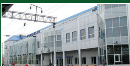
ЗАЛІЗНИЧНИЙ ВОКЗАЛ • СТАНЦІЯ "РОЗДИЛЬНА" Антикригова система
