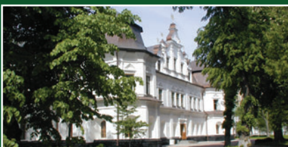
НАЦІОНАЛЬНИЙ ЗАПОВІДНИК "СОФІЯ КИЇВСЬКА" Система електрокабельного опалення
