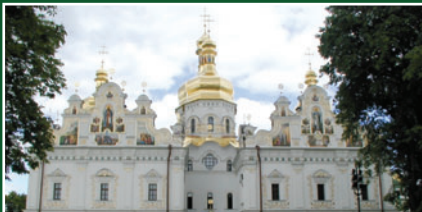
УСПЕНСЬКИЙ СОБОР КИЄВО-ПЕЧЕРСЬКОЇ ЛАВРИ Системи електрокабельного опалення та антикриги
