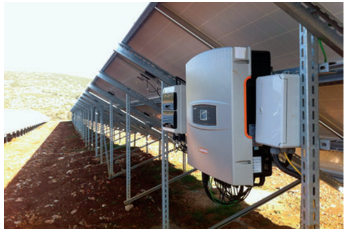
Рис. 5. Фотоэлектрические инверторы генерируют “вынужденно помехи” от 2 кГц до 150 кГц в сеть
