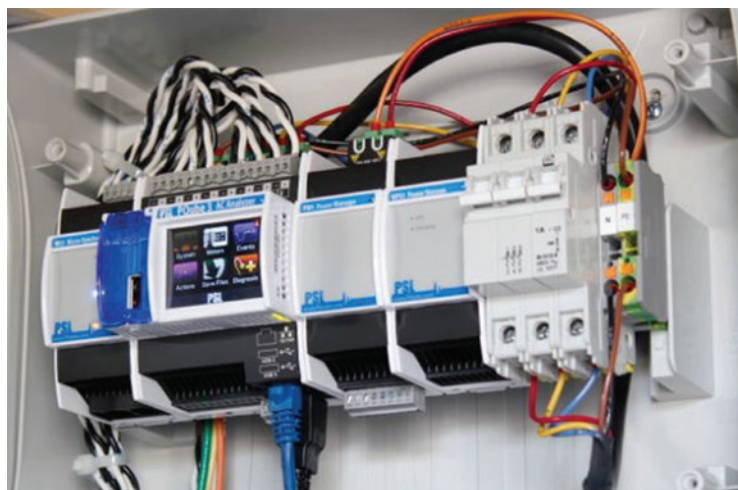
Рис. 3. Pcube 3 регистрирует супергармоники на площадке 24 часа в сутки / 7 дней в неделю
