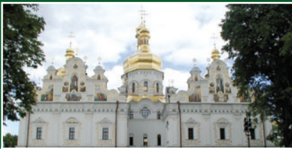
УСПЕНСЬКИЙ СОБОР КИЄВО-ПЕЧЕРСЬКОЇ ЛАВРИ Системи електрокабельного опалення та антикриги
