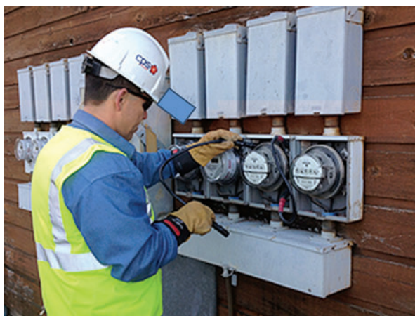
Рис. 1. Некорректные показания счетчика вызваны кондуктивными помехами при 2–150 кГц
