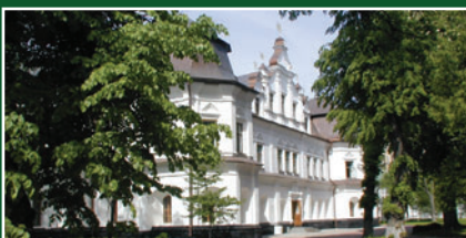
НАЦІОНАЛЬНИЙ ЗАПОВІДНИК "СОФІЯ КИЇВСЬКА" Система електрокабельного опалення
