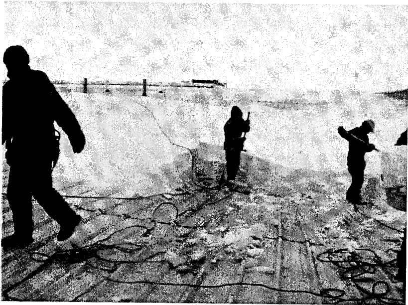
Рис. 3.13. Сніг на даху в осях 22 – 23 × А1 – В (див. рис. 3.10) до і під час прибирання на деформованій ділянці даху
