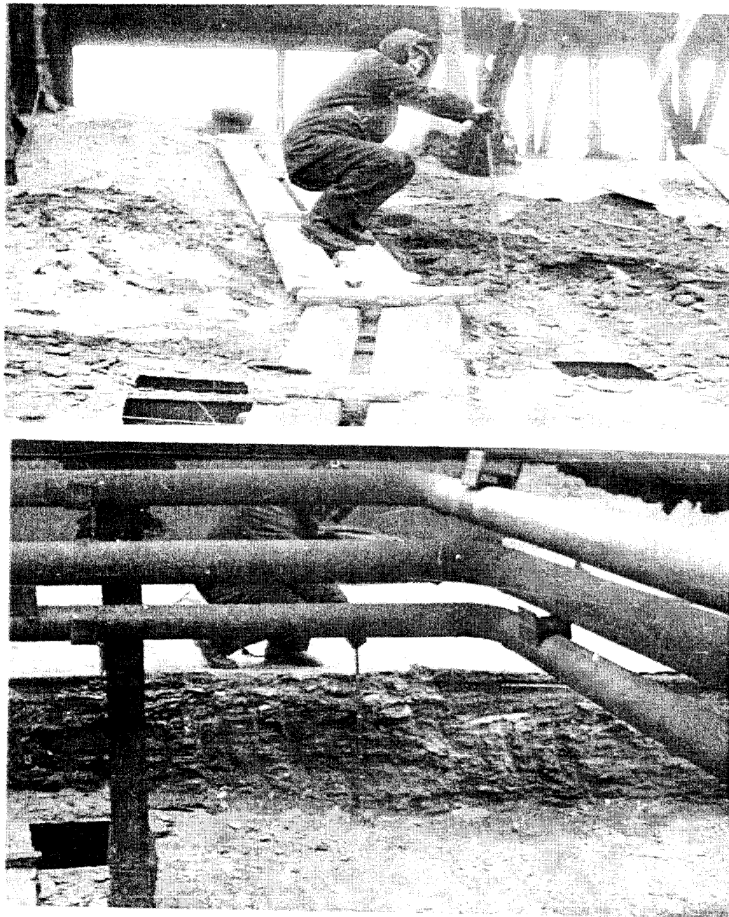
Рис.3.21. Накопичення пилу на покрівлі в осях Г–Д (верхнє фото) В–Г (нижнє фото).
