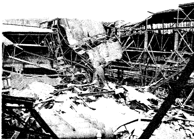
Фото 10. Обвалення покриття термокалібрувального цеху металургійного комбінату (2001 р.)
