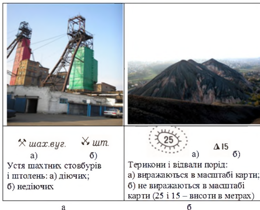
Рис. 5.28. Устя шахтних стовбурів і штولень, над якими на місцевості встановлені копри (а) і терикони (б) та їх зображення на картах
