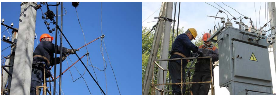
Рисунок 2.1 – Фото електромонтерів під час проведення ремонтних робіт
