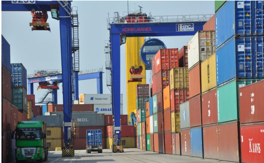
Рисунок 4.4 – Контейнерний термінал Одеського порту
