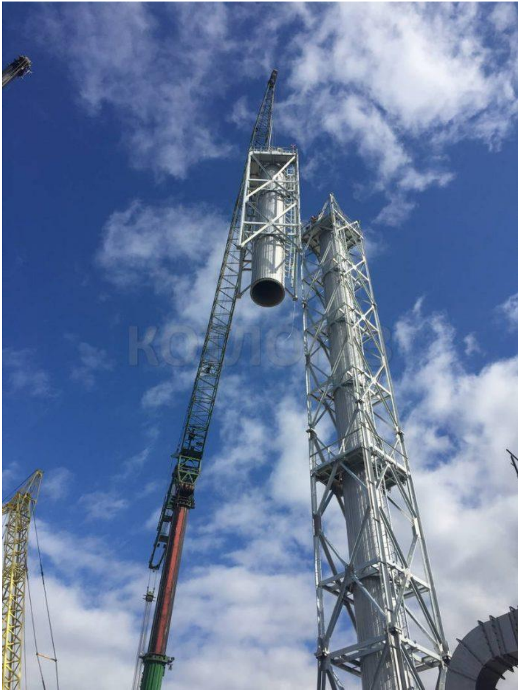
Рисунок 2.24 – Монтаж димової труби краном (окремими царгами)
