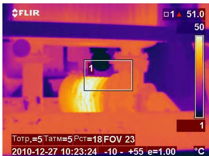
Рисунок 3 – Перегрітий електродвигун маслососа системи охолодження
