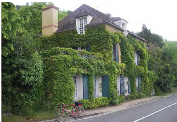
Рис. 5 – Вертикальне озеленення фасадів будівлі
