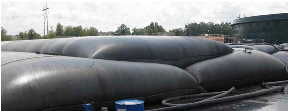
Рисунок 5 - Зневоднення та зберігання річкового мулу у геотубах.
