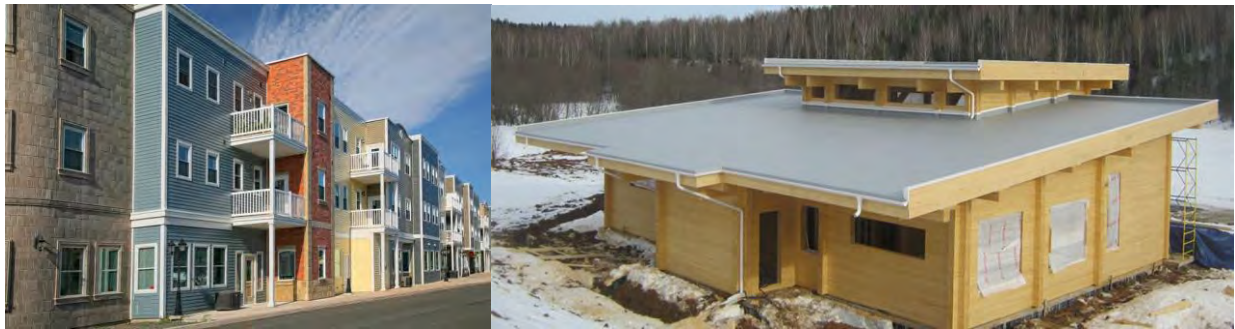
Рис. 2. Багатоквартирні і індивідуальні будинки з плоским дахом
