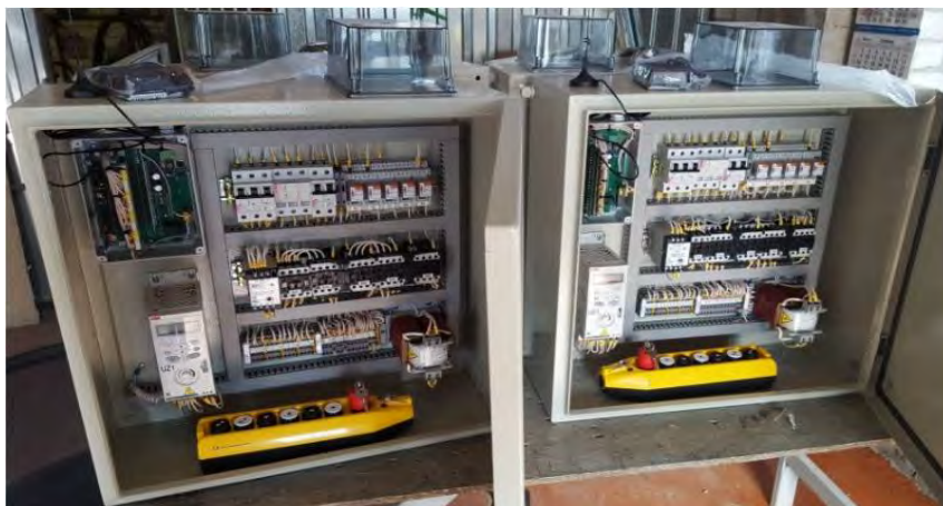
Рис. 1 - Система дистанційного керування краном
