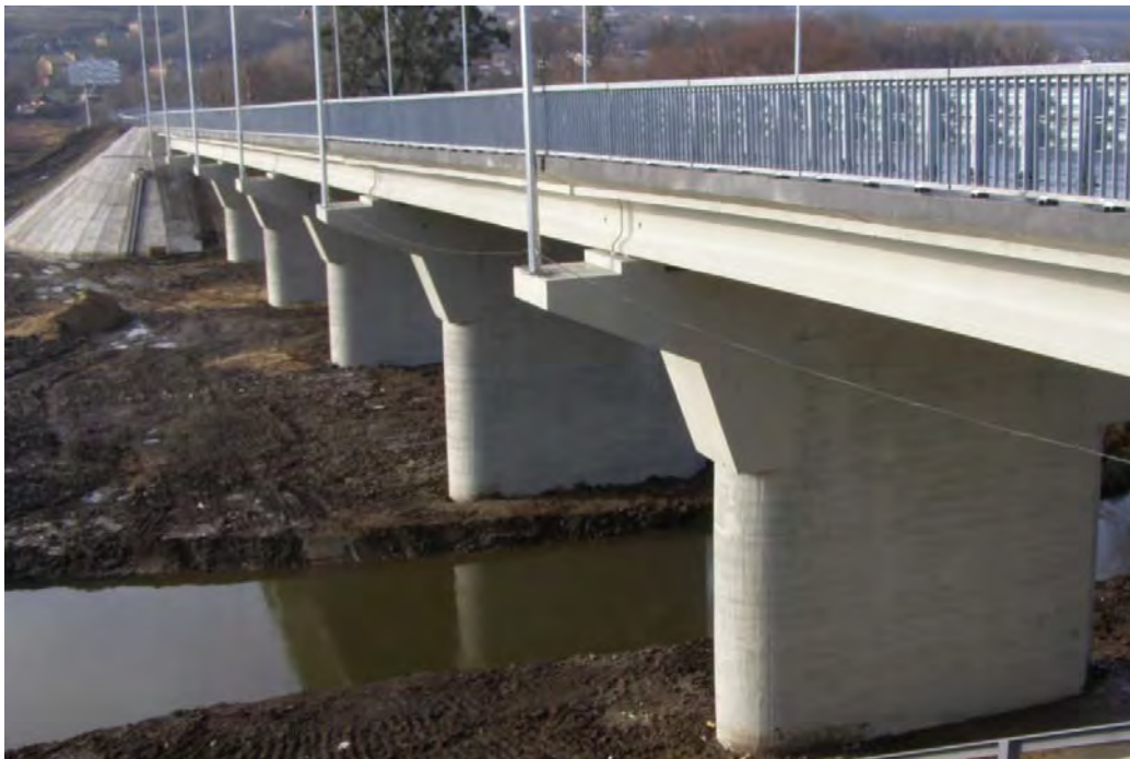
Рис 3. Загальний вигляд мостової опори після реконструкції.
