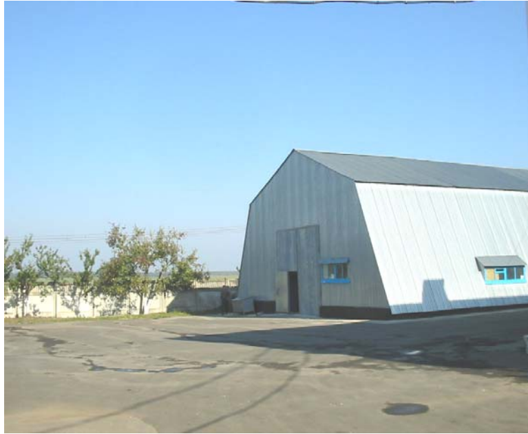
Рисунок 5.7 - Цех гумо-технічних виробів служби ремонтів Південно-Західної електроенергетичної системи
