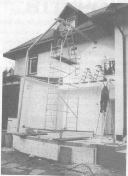
Спочатку встановлюють гребінь (коньок) даху
