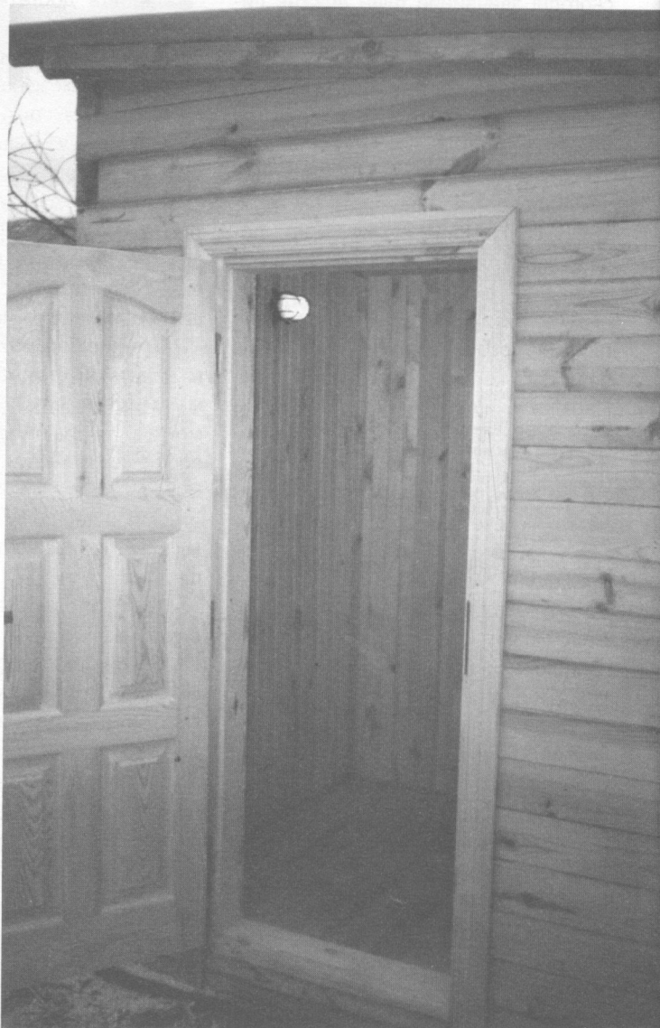
У спрощеному варіанті стіни бані можуть бути виконані з прямокутного бруса
