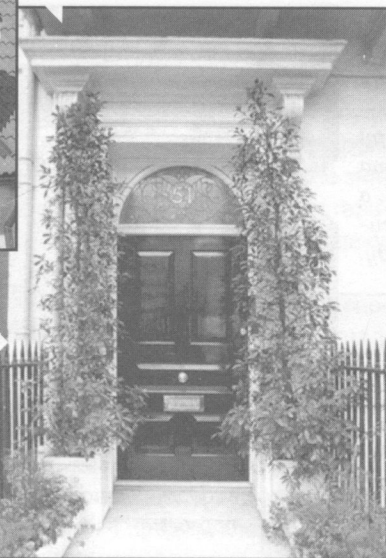
Рис. 11. Трикутний сандрик у вигляді фронтона.
