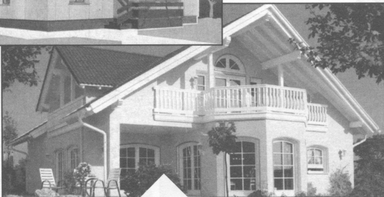
Рис. 7. Будинок з шестикутним еркером, на перекритті якого влаштовано невеличку терасу. Балюстрада з простих, але досить виразних дерев'яних баясин, які огорожують терасу і декоративно розміщуються на частині стіни.
