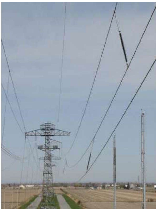
Рисунок 4.10 – Ілюстрація застосування міжфазних демпферних розпірок
