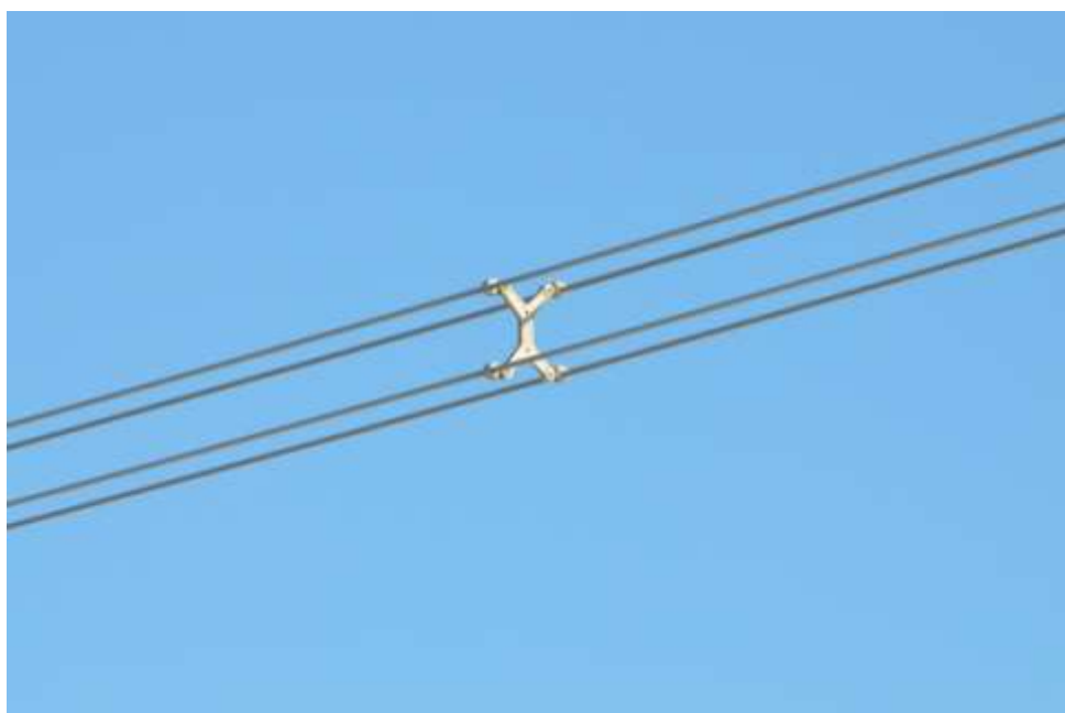
Рисунок 4.11 – Ілюстрація застосування внутрішньофазних дистанційних антивібраційних розпірок
