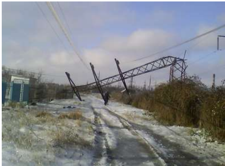
Рисунок 4.2 – Аварії на ЛЕП, пов'язані із ожеледдю
