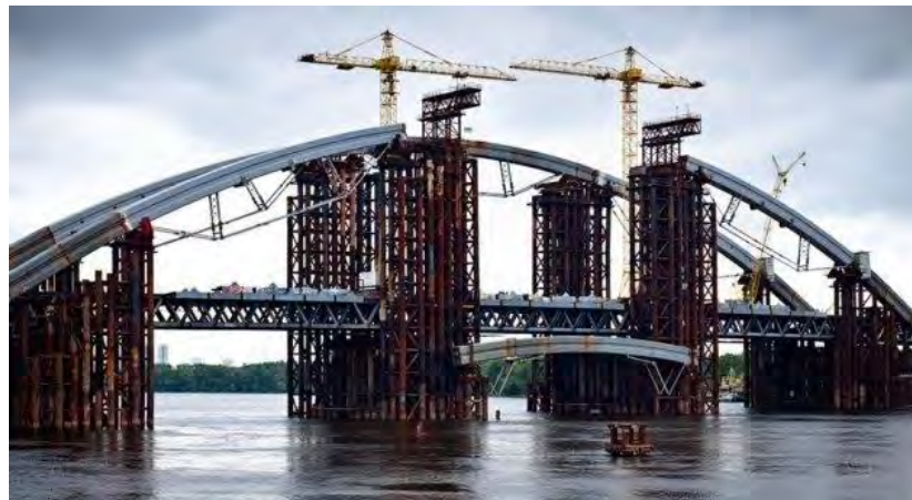
Рисунок 2 – Іржавий міст – дія механізму електрохімічної корозії
