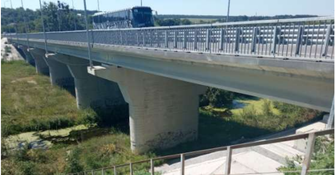
Рисунок 2.2 – Висоководний балочний балковий автомобільний міст у м. Гайсин, Вінницька область, з їздовим полотном по верху мостової споруди та жорсткими опорами. Проект і фотографія Попова В. О.
