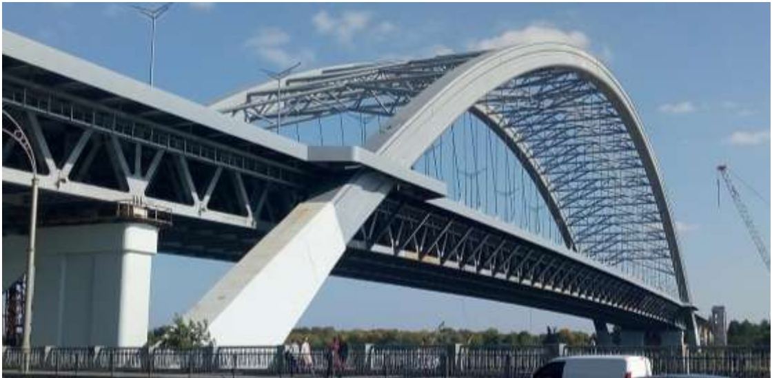
Рисунок 2.4 – Арково-підвісний автомобільний міст через р. Дніпро у м. Київ з їздовим полотном в рівні середньої лінії арки. Фотографія взята з джерела [13]
