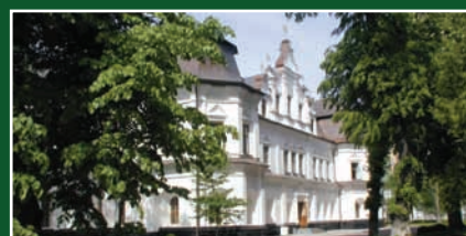
НАЦІОНАЛЬНИЙ ЗАПОВІДНИК "СОФІЯ КИЇВСЬКА" Система електрокабельного опалення
