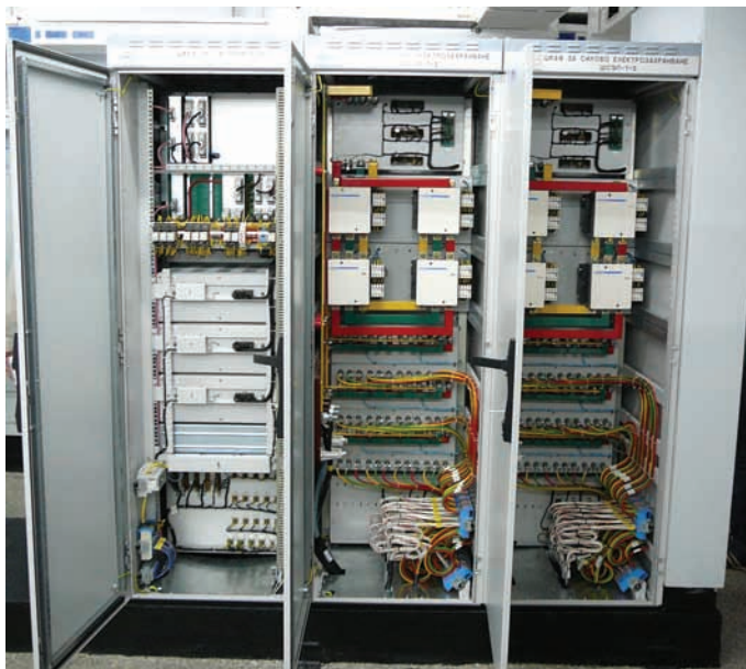
Багатофункціональні електричні комірки 0,4 кВ
