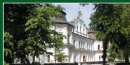
НАЦІОНАЛЬНИЙ ЗАПОВІДНИК "СОФІЯ КИЇВСЬКА" Система електрокабельного опалення
