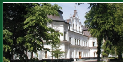
НАЦІОНАЛЬНИЙ ЗАПОВІДНИК "СОФІЯ КИЇВСЬКА" Система електрокабельного опалення
