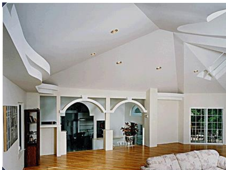
Рис. 15.4 – Использование гипсокартона для отделки стен, потолков и устройства перегородок в помещениях
