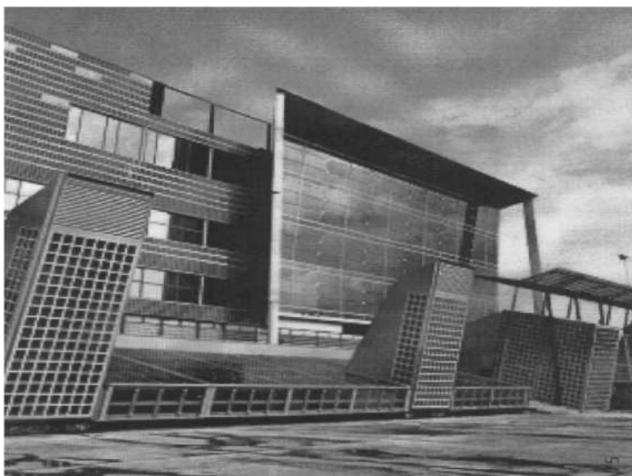
Бизнес-центр в Испании. Утепление инверсионной кровли изделиями URSA FOAM
