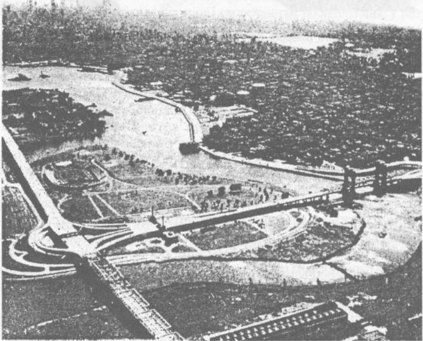
Іл. 2-106. Транспортна розв'язка типу "листа конюшини" (Нью-Йорк-сіті, о. Рендолл, 1936 р.). Такі магістралі з широкими під'їзними шляхами, численними простими або складними багаторівневими розв'язками є прикладом сучасних крупномасштабних вирішень, що відображають можливості конструкції і просторово-часової концепції містобудування та архітектури
