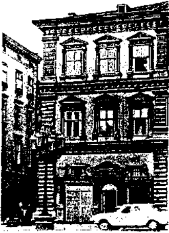
Іл. 3-102. Львів, площа Ринок, будинок № 2 – палаццо Бандінееллі (арх. П. Полейовський, кінець XVI ст.), побудований у стилі пізнього ренесансу Джерело: [31, с. 90]
