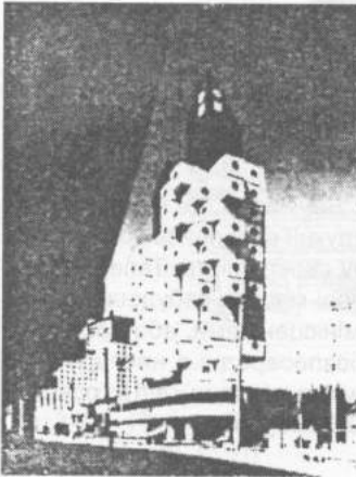
Іл. 3-70. Токіо. Накагін, Капсул-білдінг, (арх. К. Курокава, 1972 р.). 140 капсул-блоків були доставлені на будівельний майданчик і підняті на двох бетонних стовпах. Житло обладнане сучасною побутовою апаратурою та пристроями
