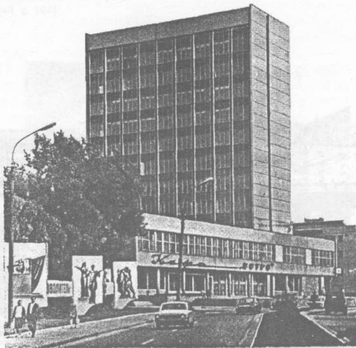
Іл. 3-143. Будинок обчислювального центру на проспекті Чорновола (арх. М. Вендзилович, 1969 р.)
