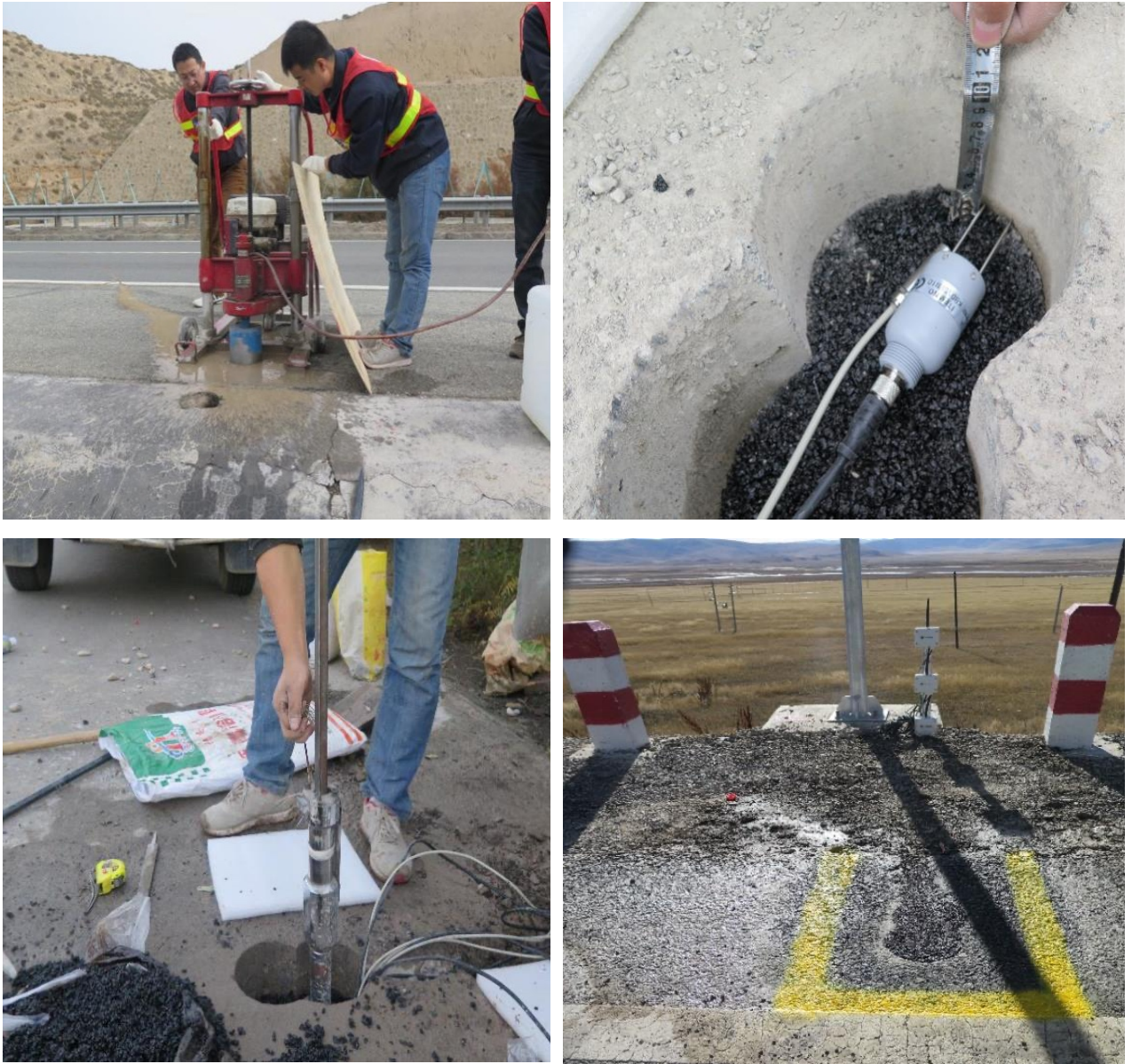
Рисунок 2.1 – Технологія встановлення датчиків
