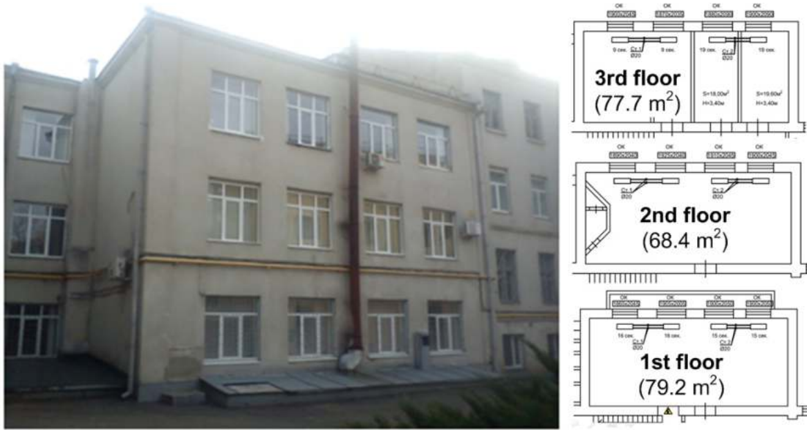
Рисунок 4.1 – Загальний вигляд та технічні характеристики будівлі обраної для досліджень ефективності «розумного» опалення
