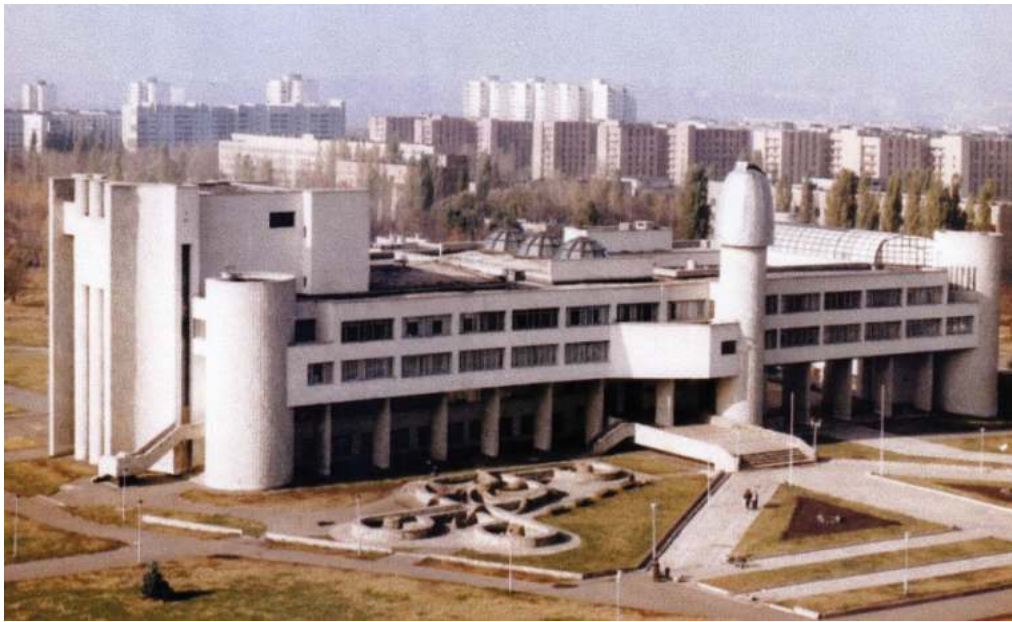
Рисунок 3.1 – Загальний вигляд досліджуваної будівлі закладу освіти
