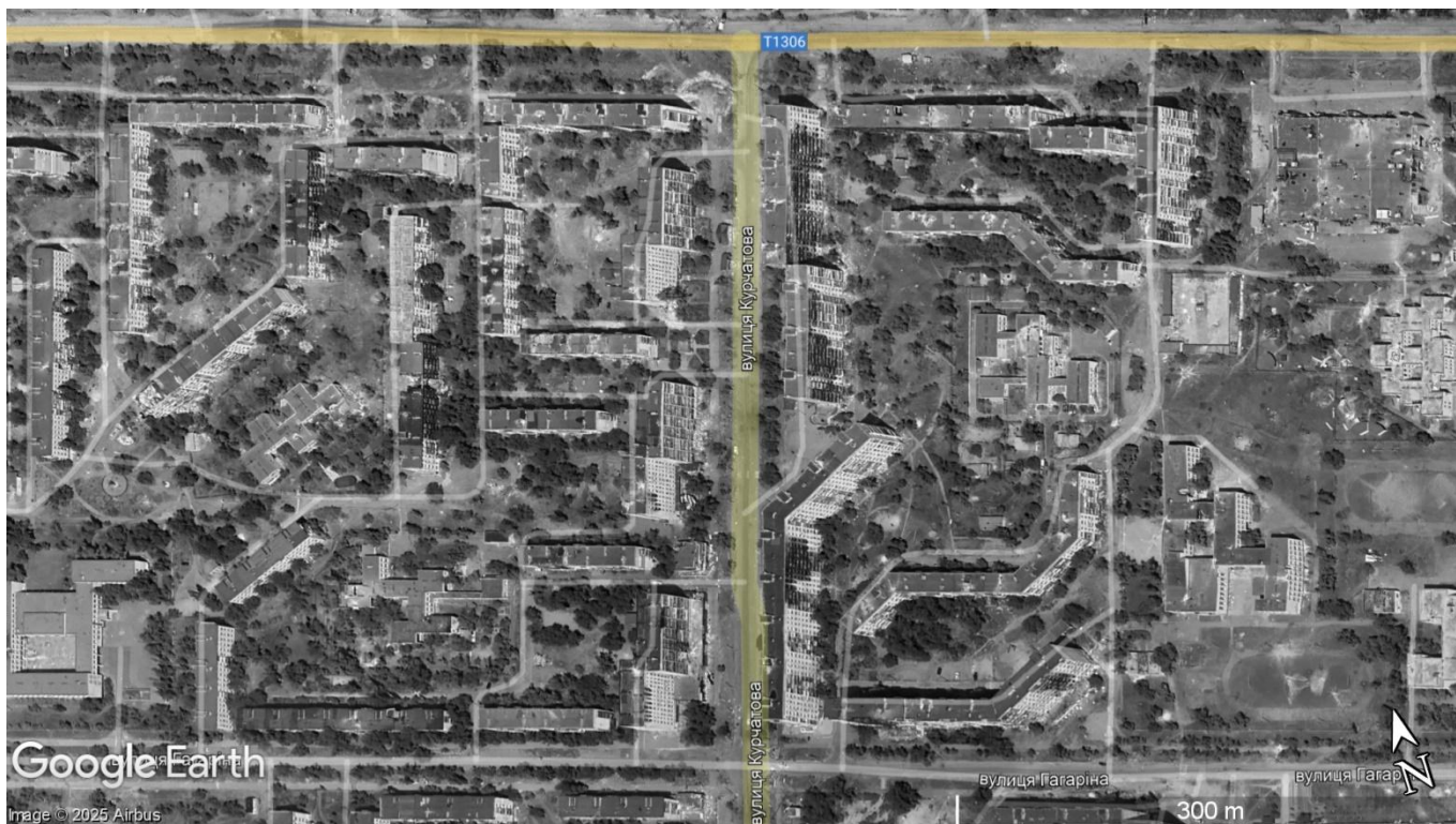
Рисунок 2.5 – 9-ти поверхова забудова кварталу великопанельними будинками (м. Сіверськкодонецьк)
