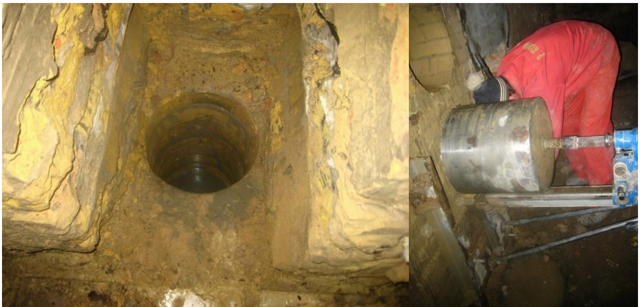
Рисунок 3.1 – Вибурювання під набивні палі за допомогою алмазної установки [203]
