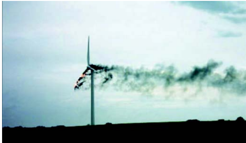
Рисунок 7.1 – Фото пожежі на вітрогенераторі з причини короткого замикання в проводах
