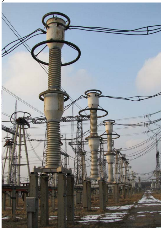
Рисунок 2.11 – Трансформатори струму для зовнішньої (а) та внутрішньої (закритої) експлуатації (б)
