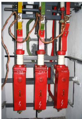
Рисунок 6.1 – Вимикач ВМГ-133
