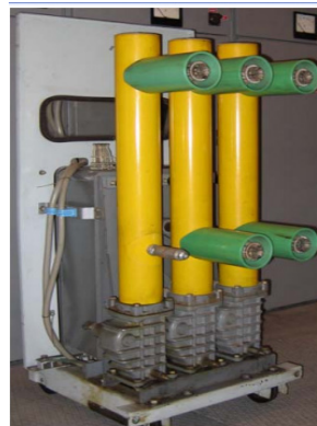
Рисунок 6.2 – Вимикач на викочуваному елементі
