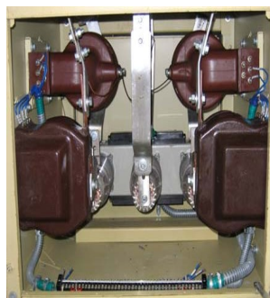
Рисунок 6.4 – Вакуумний вимикач, встановлений в комірці К–112
