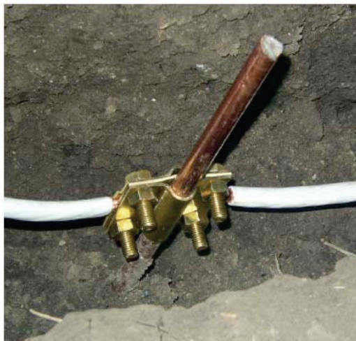
Рисунок Б.2 – Глибинний заземлювач типу А у траншеї
