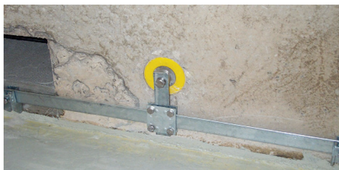
Рисунок В.2 – З'єднання арматури, заземлення та металоконструкцій з шиною зрівняння потенціалів напряму та через контактну колодку
