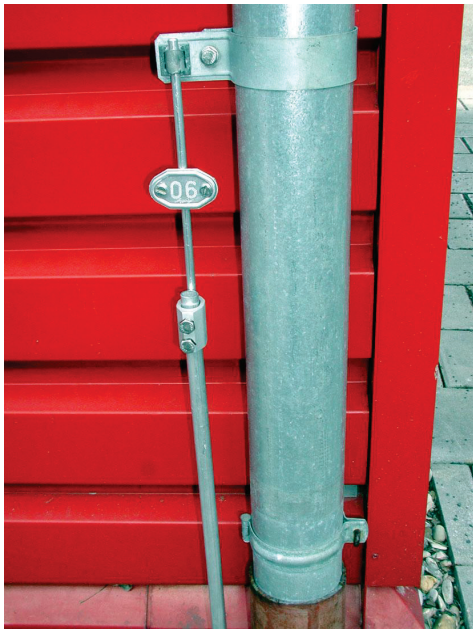
Рисунок А.22 – Використання природних компонентів як струмовідводів
