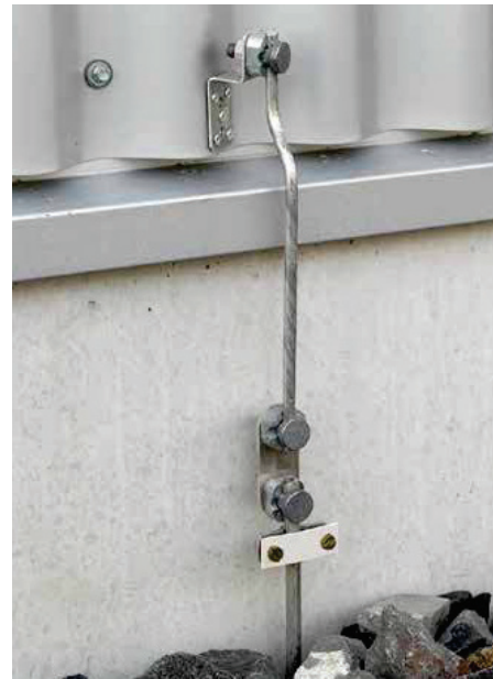
Рисунок А.19 – Приклади влаштування контрольних точок заземлення
