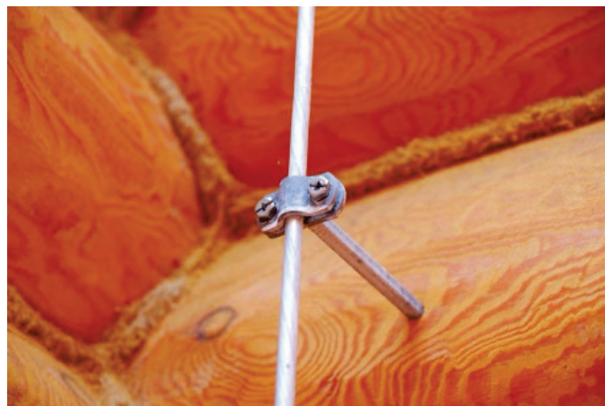
Рисунок А.21 – Кріплення струмовідводів на дерев'яну поверхню
