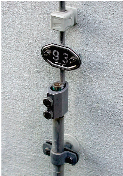
Рисунок А.19 – Приклади влаштування контрольних точок заземлення
