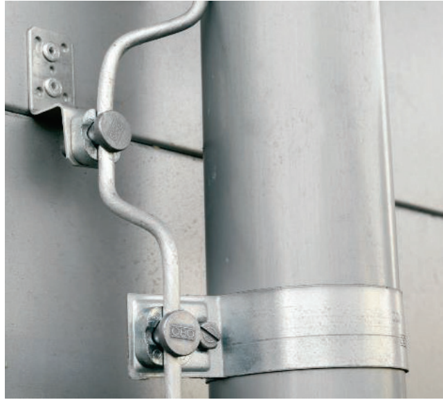
Рисунок А.22 – Використання природних компонентів як струмовідводів
