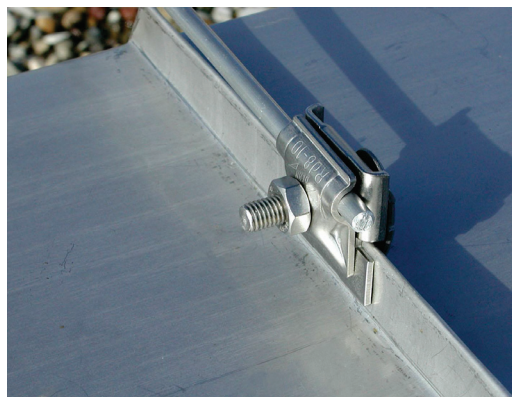
Рисунок А.18 – Фальцеві (шовні) клеми для кріплення провідників на металевих покрівлях
