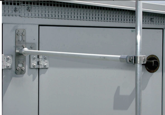
Рисунок А.4 – Кріплення стрижня блискавкоприймача за допомогою додаткових склопластикових тримачів
