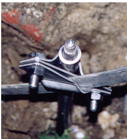
Рисунок Б.2 – Глибинний заземлювач типу А у траншеї
