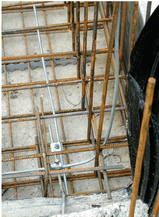
Рисунок Б.8 – Приклад прокладання провідників фундаментного заземлення типу В та з'єднання з арматурою
