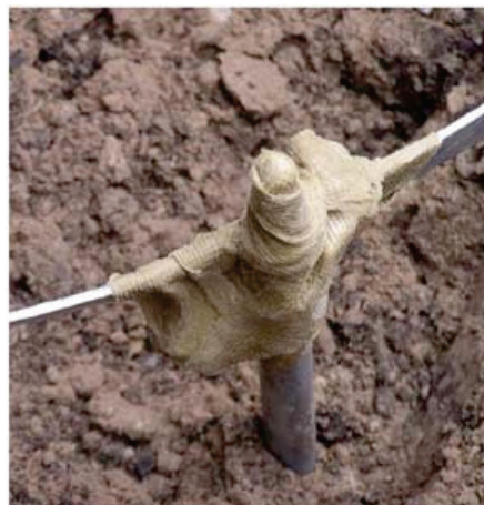
Рисунок Б.4 – Захист від корозії за допомогою антикорозійного бандажу
