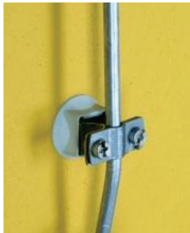
Рисунок А.20 – Кріплення струмовідводів до стіни
