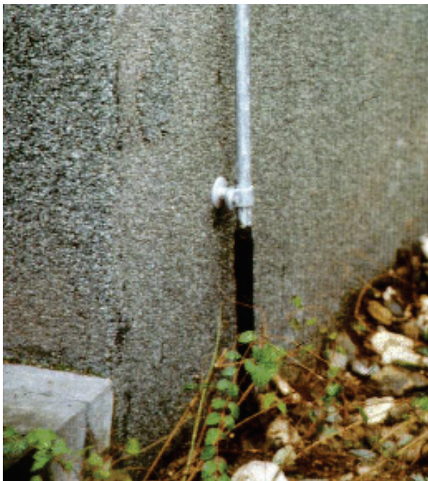
Рисунок Б.6 – Захист від корозії точки з'єднання струмовідводу та заземлювача; розміщення контрольної точки з'єднання у стіні
