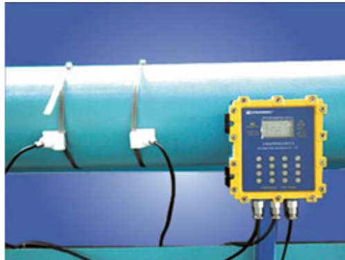
Рисунок 4.10 – Зовнішній вигляд ультразвукового витратоміра з накладеними сенсорами DMTFB-Eх компанії «ПРОМПОСТАВКА» [11]
