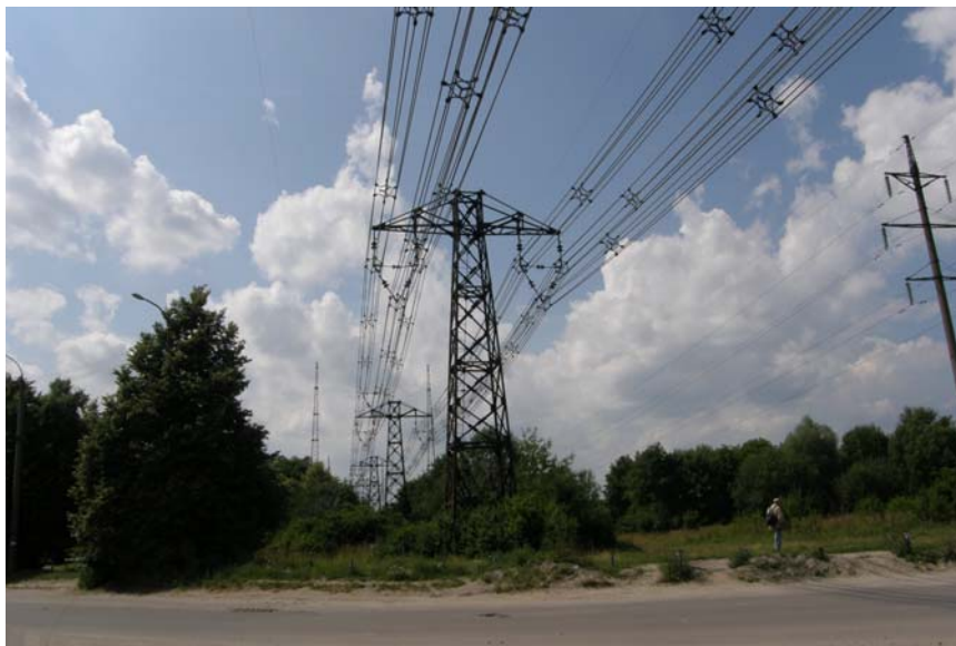
Рисунок 2.29 – Компактна повітряна лінія електропередавання напругою 10 кВ
